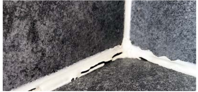
Geschädigte elastische Dehnungsfuge
