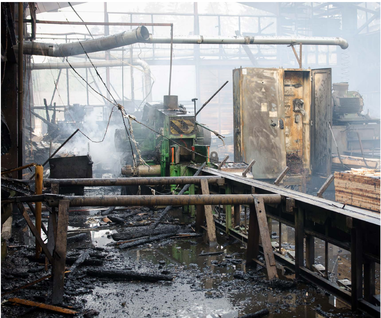
Brandschaden in einem Sägewerk
